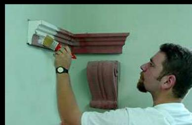
**Anwendungsbereich:** zur dekorativen, stilvollen Gestaltung oder Verschönerung von Fassadenflächen. Gut geeignet zur Anwendung und Ergänzung auf WDVS Hartschaum-Dämmplatten und WDVS Mineralwolle-Dämmplatten. Auch anzubringen auf unbehandeltem Putz und unbehandeltem Beton. Der Untergrund muss sauber, fest, trocken, tragfähig und frei von Ausblühungen und Trennmitteln sein. Die Untergrundvorbehandlung muss den jeweiligen Untergrundverhältnissen angepasst sein.
